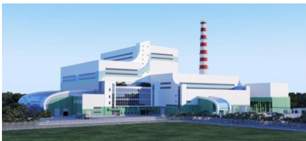
モスクワのごみ焼却発電プラント
