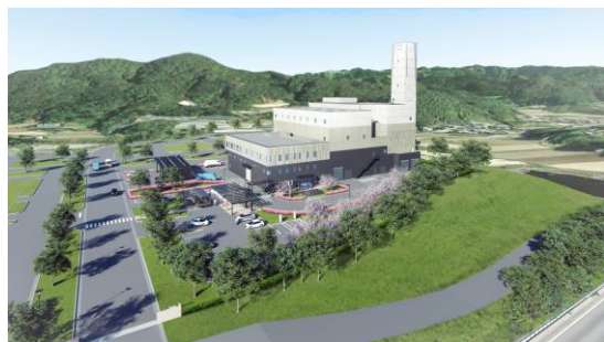
宇城広域連合エネルギー回収型廃棄物処理施設
