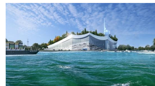
中国・上海市のごみ焼却発電プラント
