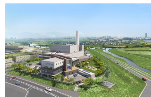
佐賀県東部ごみ処理焼却発電プラント
