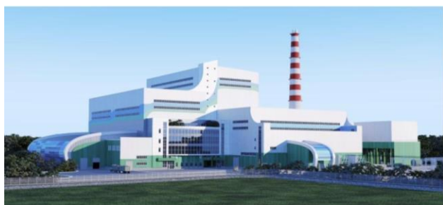
モスクワのごみ焼却発電プラント
