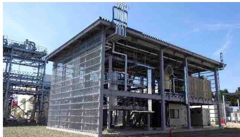
INPEX 長岡鉱場の越路原プラント敷地内に新設
