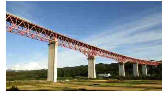
片品川橋全景
