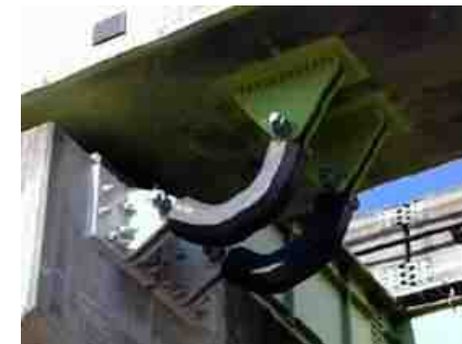
耐震補強の一例： ゴム被覆チェーンによる橋桁連結
