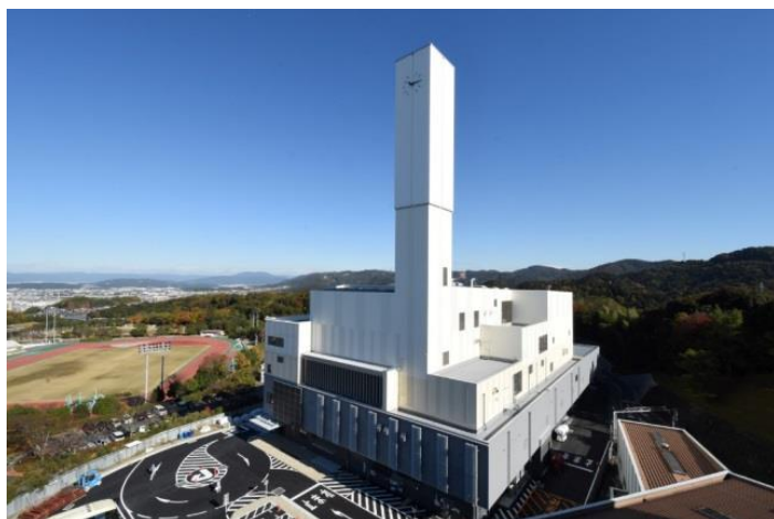
クリーンパーク折居の外観
