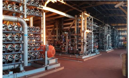
逆浸透膜（RO 膜）を使用した水処理設備（左:イメージ、右:既設設備）
