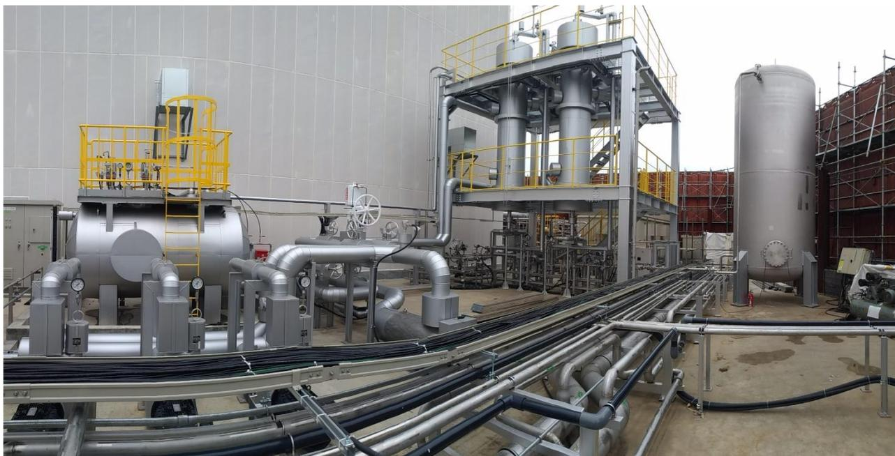
本実証設備で生成されるメタンは、商業用天然ガスのサテライト供給設備に匹敵する 125N m<sup>3</sup>/h で国内最大であり、清掃工場から排出される二酸化炭素を利用したメタネーションは世界初となります。生成されたメタンは、メタンガス利用設備で燃焼確認、発電確認をおこないます。
