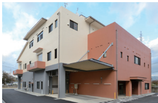
【海津木苑（汚泥再生処理施設、福岡県古賀市）】
