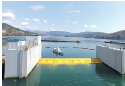
岩手県（細浦漁港）向け海底設置型フラップゲート式水門
