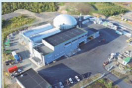
■ メタン発酵施設 (バイオガスプラント)
