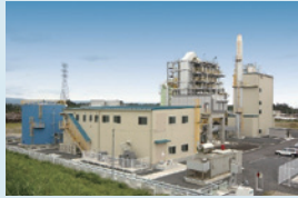
■ バイオマス発電プラント
