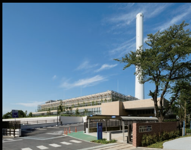
東京二十三区清掃一部組合 杉並清掃工場
