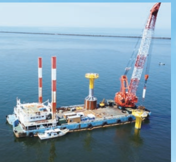
▲NEDO助成事業/ 洋上風力発電低コスト施工技術開発 (サクシオンバケット基礎施工技術実証)/ 実証試験体の施工試験 (写真提供: 東洋建設株式会社)
