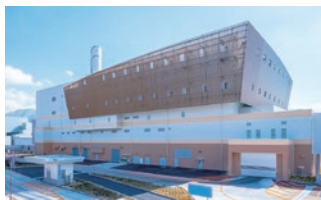
●ごみ焼却発電施設
