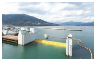
● フラップゲート式水害対策設備
