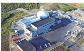
●バイオガスプラント
