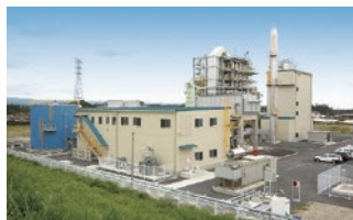
●バイオマス発電プラント
