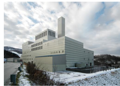
北しりべし広域クリーンセンター
