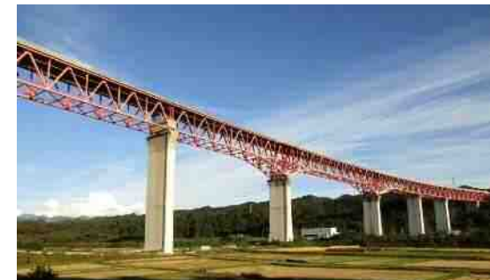
片品川橋全景
