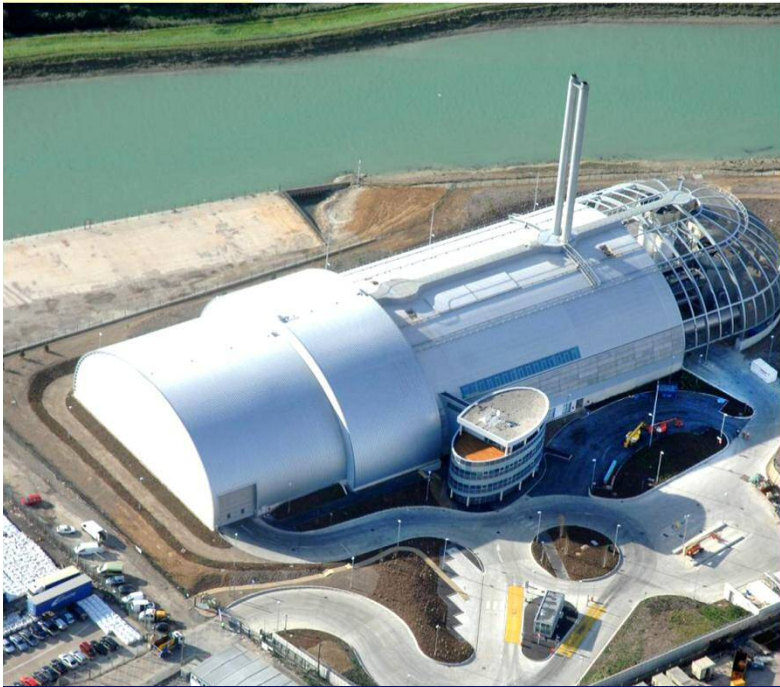
イングランド南東部 ニューヘヴン ごみ焼却発電施設 (ごみ処理能力696t/日 発電能力19.3MW)
