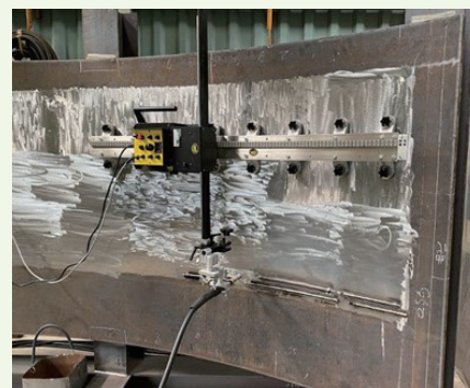
現地用自動補修装置の外観
