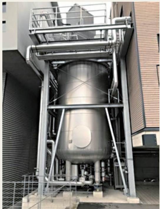
図1 メタネーション反応槽、容量50 m 3 ©Limeco
