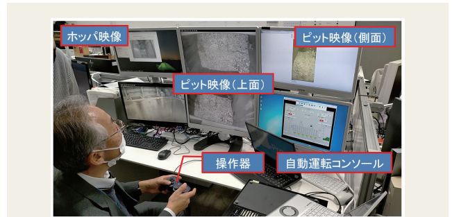
図8 ごみクレーンの遠隔手動運転の状況
