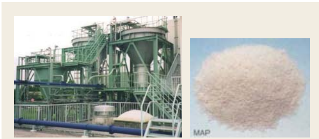
図2 宍道湖東部浄化センターの フォスニックス設備と回収MAP結晶の外観
