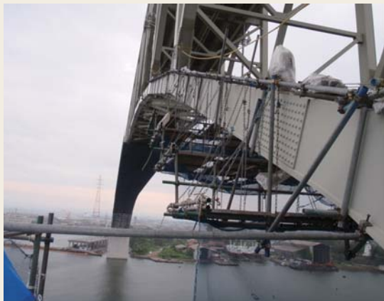
図8 下弦材吊足場組立状況
