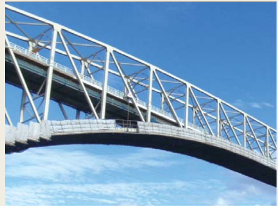
図9 下弦材吊足場組立完了
