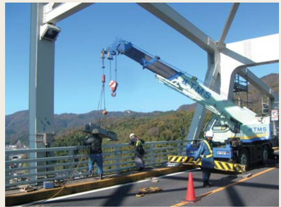
図10 補強部材取付け状況
