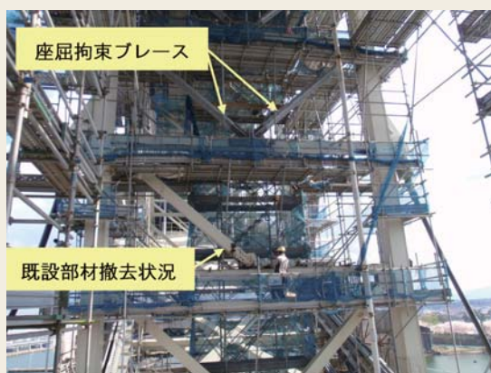
図12 座屈拘束ブレース設置状況
