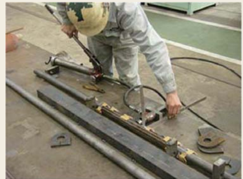
図5 変形したパイプの矯正作業
