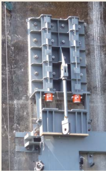
図5 浮上り防止金物
