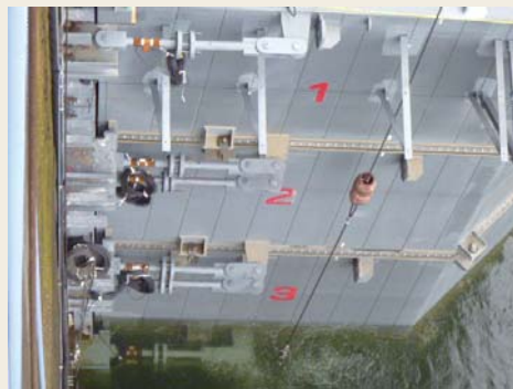
図6 扉間連結金物と緊定金物
