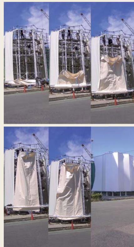
図7.1 施工検証状況
