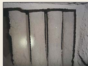
図19 排エコの汚れ状況(硫黄分3.5%、155時間後)
