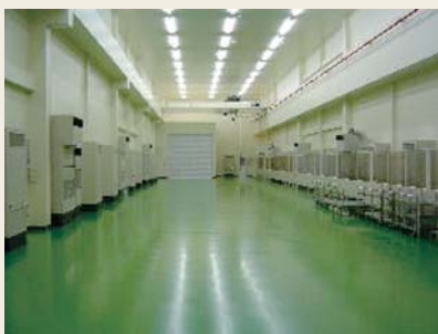
図3.6 東舞鶴工場 クリーンルーム
