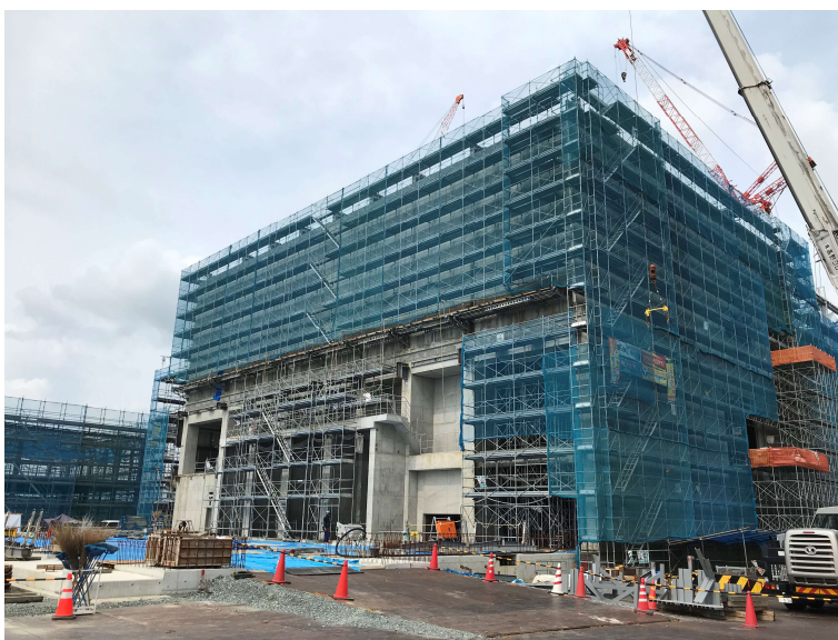
写真-2 菊池環境保全組合新環境工場(ごみ処理施設)整備及び運営事業 2021年3月 竣工予定
