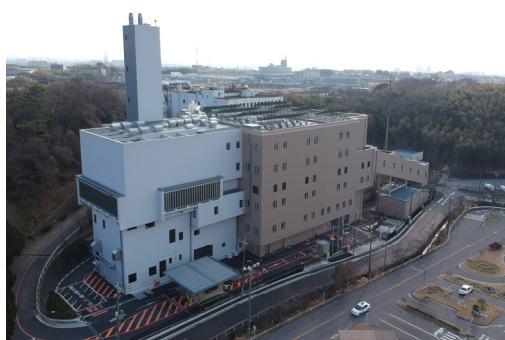
Neyagawa-shi Clean Center
