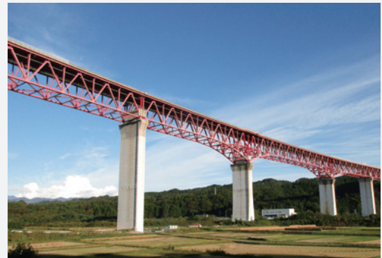
Katashinagawa Bridge (Kan-Etsu Expressway)
