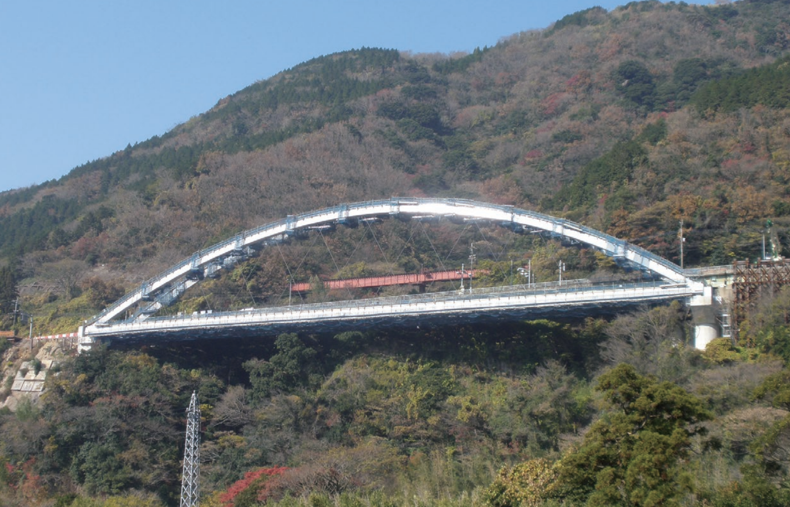
▲ Bikunitani bridge (Kumamoto Prefecture)
