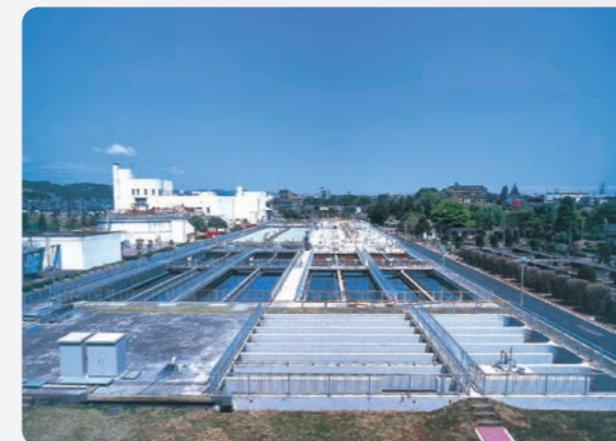
Hanno Purification Center
