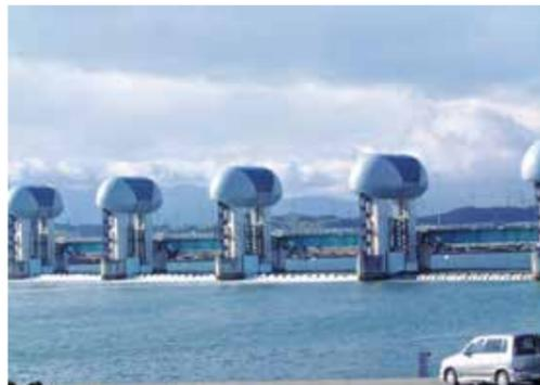
シェル構造ローラゲート Shell type fixed wheel gate
