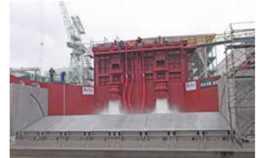
陸上設置型フラップゲート式防波堤「neo RiSe®」 neo RiSe® land-mounted Flap-gate type seawall system
