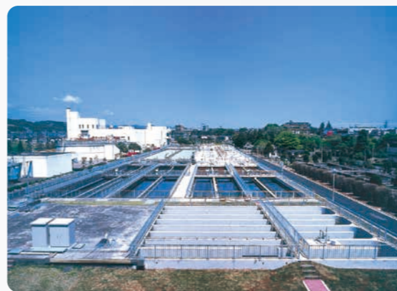
飯能市浄化センター
