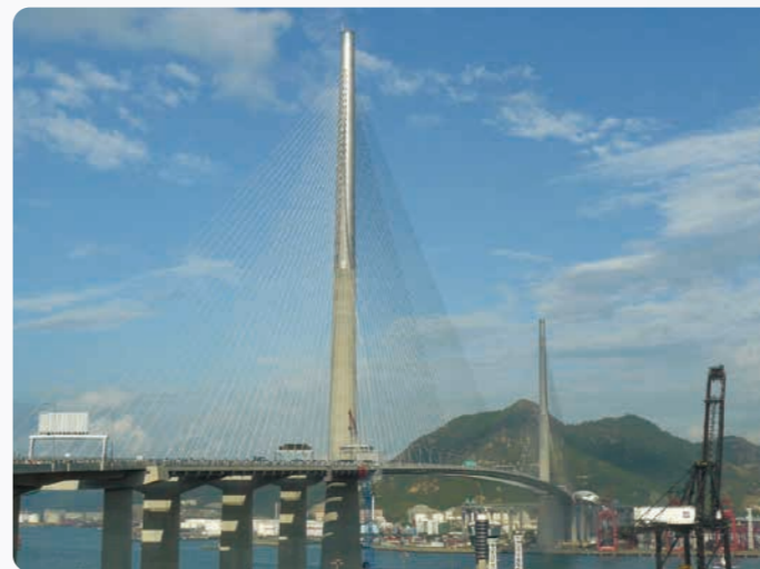
● 橋梁 日本の長大橋梁の先駆けとなった若戸大橋をはじめ、明石海峡大橋や香港のストーンカッターズ橋など国内外に2,500橋以上の豊富な実績があります。
