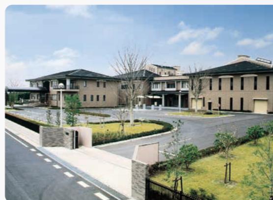
山武郡市広域行政組合/環境アクアプラント
