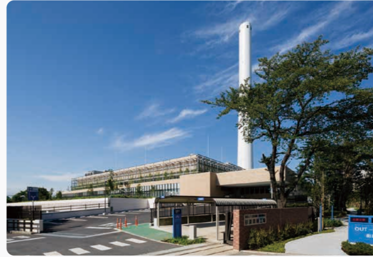
●ごみ焼却発電プラント
