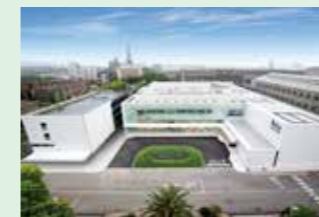
精密機械センター Precision Machinery Center
