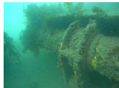
図-4.22 波除堤 扉体底部軸受（2013.3.26 撮影）
