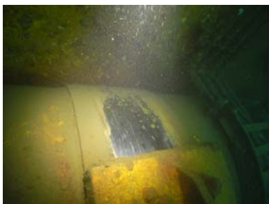
図-4.21 津波・高潮防波堤 扉体底部軸受（2013.2.28 撮影）
